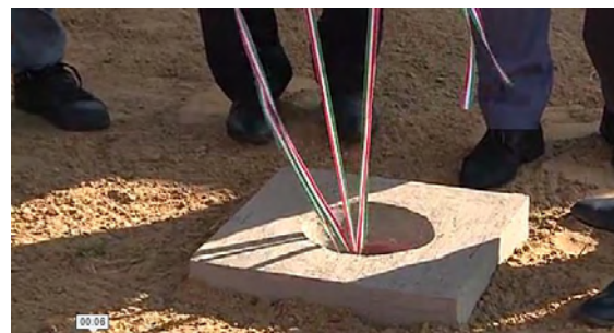
Termál víz – alapkőletétel
